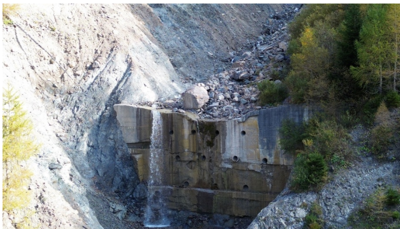
Figure 10: esempi di briglie presenti lungo l'asta principale del torrente Moscardo, censite nel 2024. a) briglia n. 190 parzialmente sovralluvionata; b) briglia n. 280 completamente distrutta; c) briglia n. 290 realizzata nel 2014 e pesantemente danneggiata; d) briglia n. 310 parzialmente sovralluvionata; e) briglia n. 320 realizzata negli anni '80 e attualmente danneggiata.
