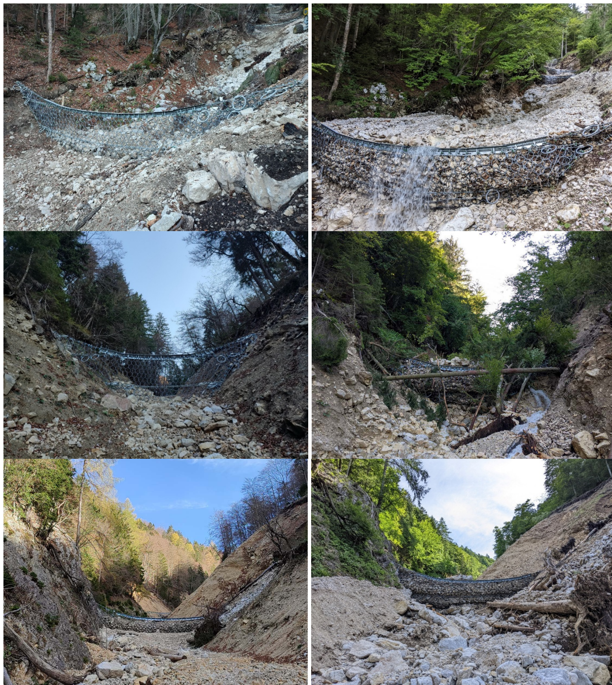
Figure 12: esempi di briglie presenti lungo l'asta del torrente Krvavec. a) briglia n. 010 appena realizzata nel 2022; b) briglia n. 010 dopo alcuni eventi di colata detritica nel 2023; c) briglia n. 100 appena realizzata nel 2022; d) briglia n. 100 dopo alcuni eventi di colata detritica nel 2023; e) briglia n. 150 nel 2022; f) briglia n. 150 dopo alcuni eventi di colata detritica nel 2023.
